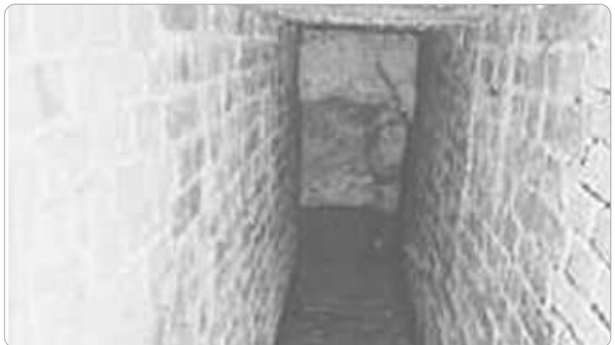
Die Quelle vor der Sanierung
