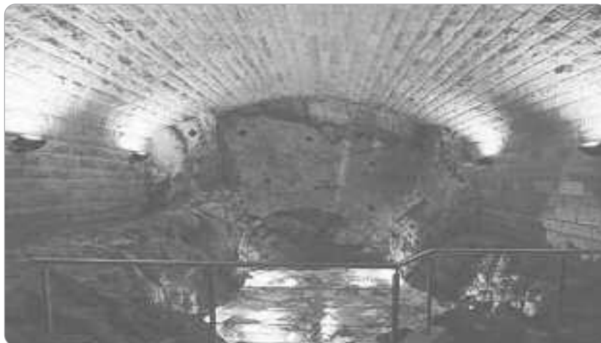
Die Quelle nach der Sanierung
