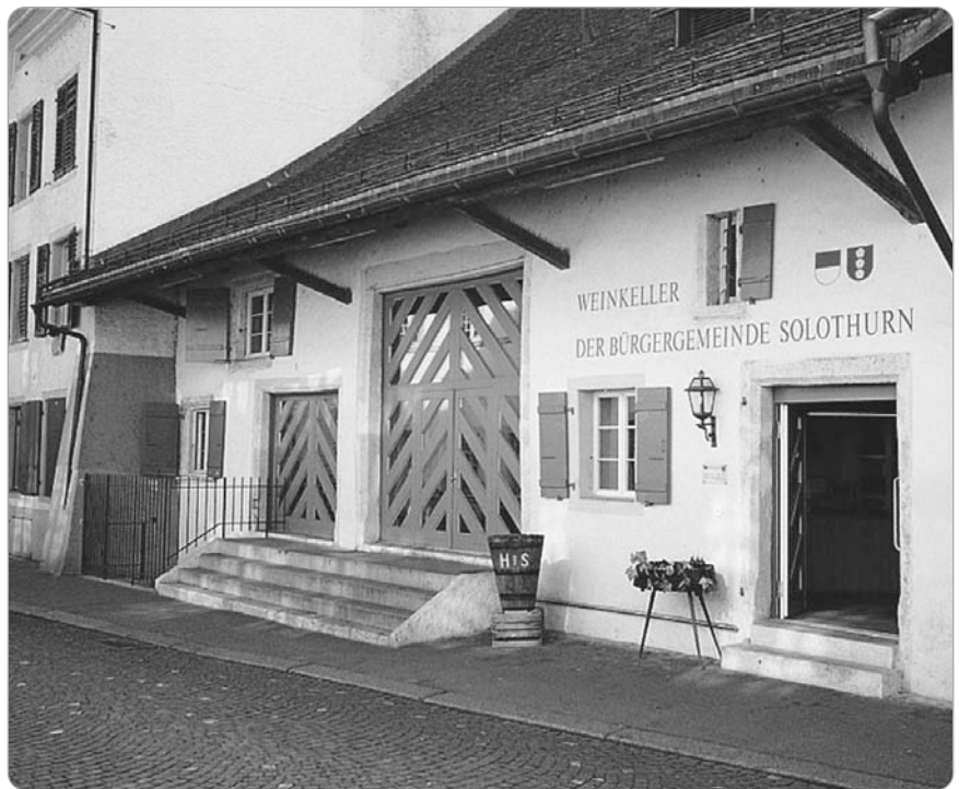
Weinkeller/Ladenlokal in Solothurn (Aussenansicht)
