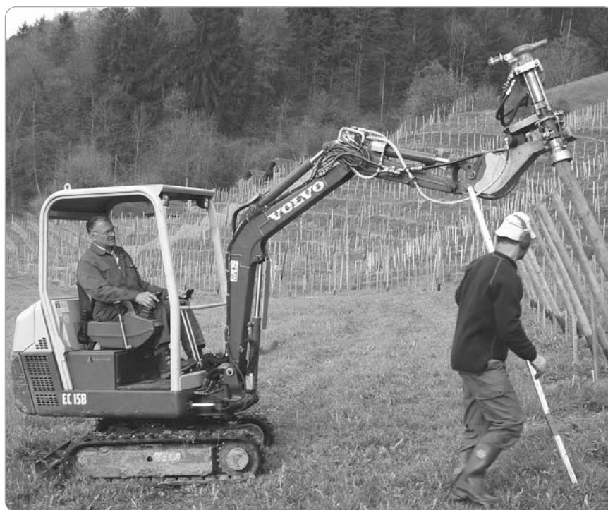
Peter Krummenacher (rechts) beim Erstellen der Solarisanlage
