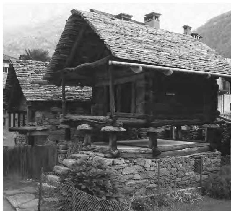
ECCO LA TORBA DI MOGHEGNO, RESTAURATA ALCUNI ANNI ORSONO
