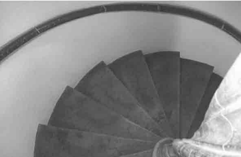
L'ESCALIER EN COLIMAÇON
