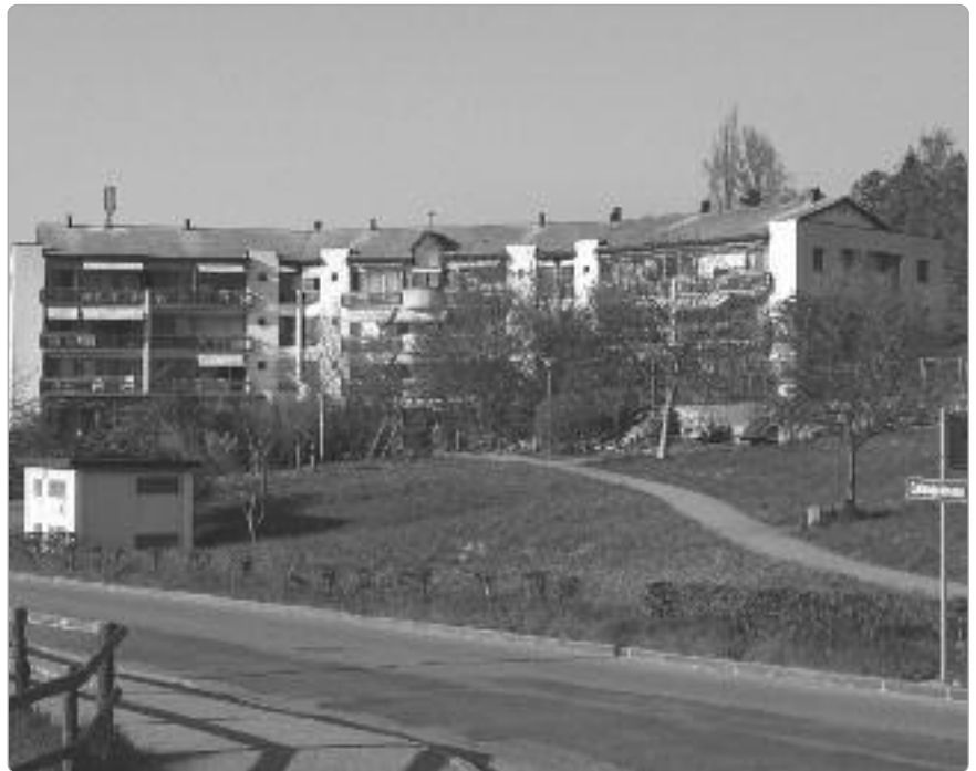
Das Bürgerheim Chur vor dem Umbau
