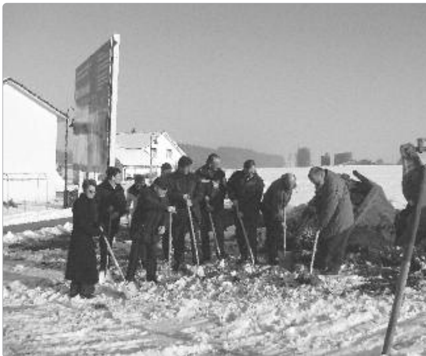
Spatenstich: Am 21. Februar 2003 nahm eine intensive Bautätigkeit seinen Anfang.
