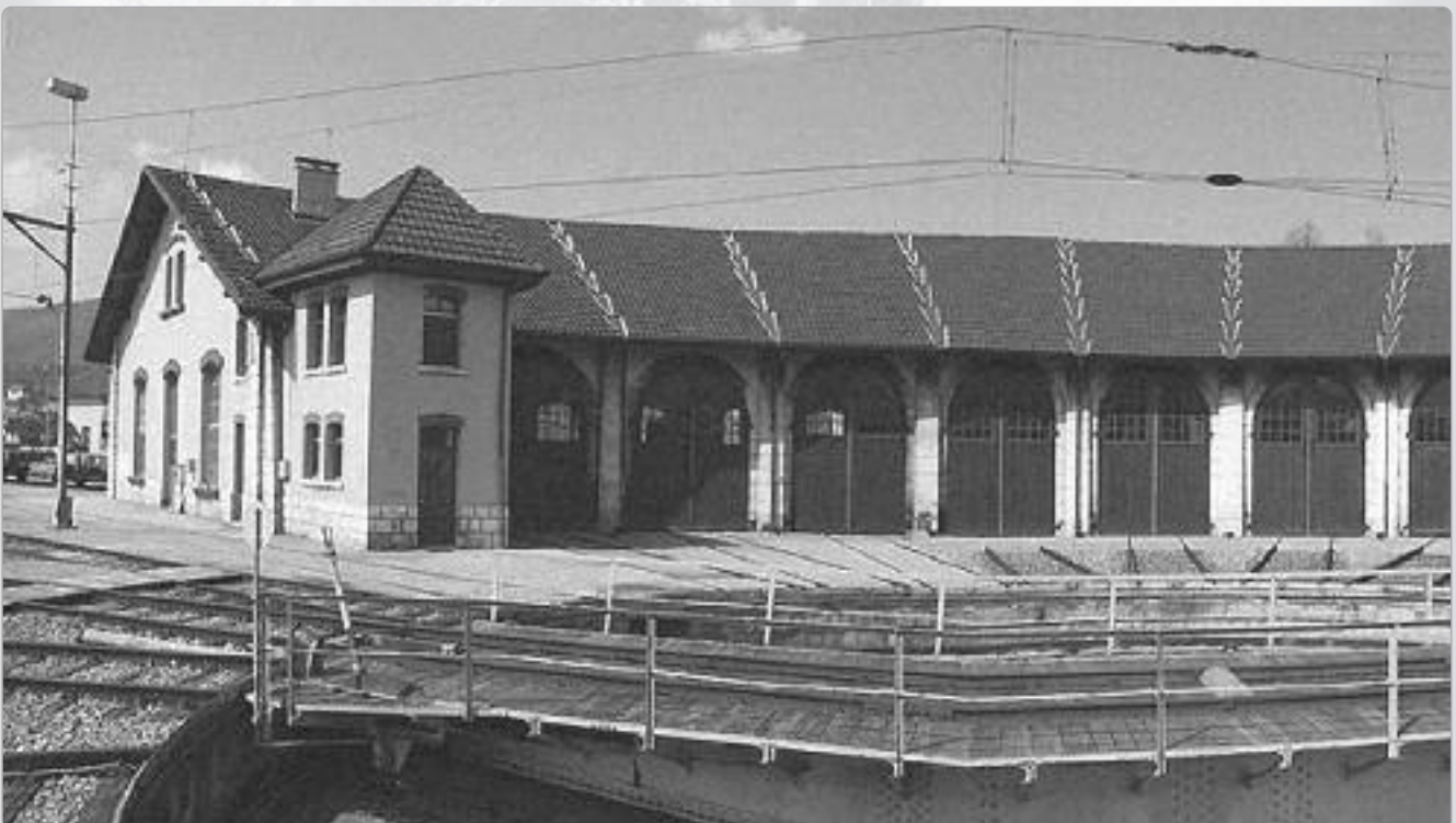
Delémont Rotonde à locomotives, Lokohof
