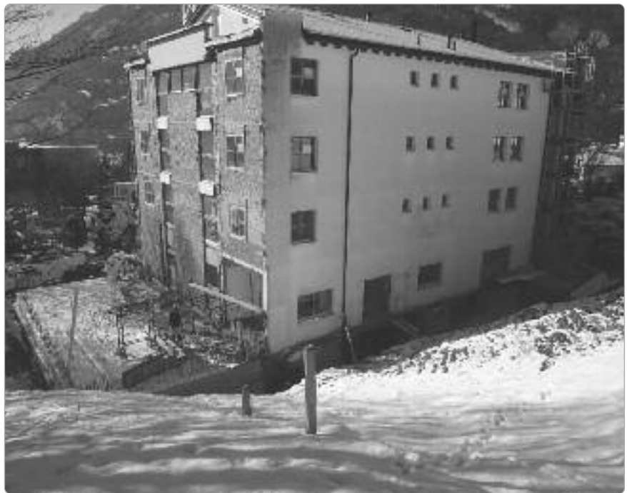
der Anbau auf der Südostseite entsteht
