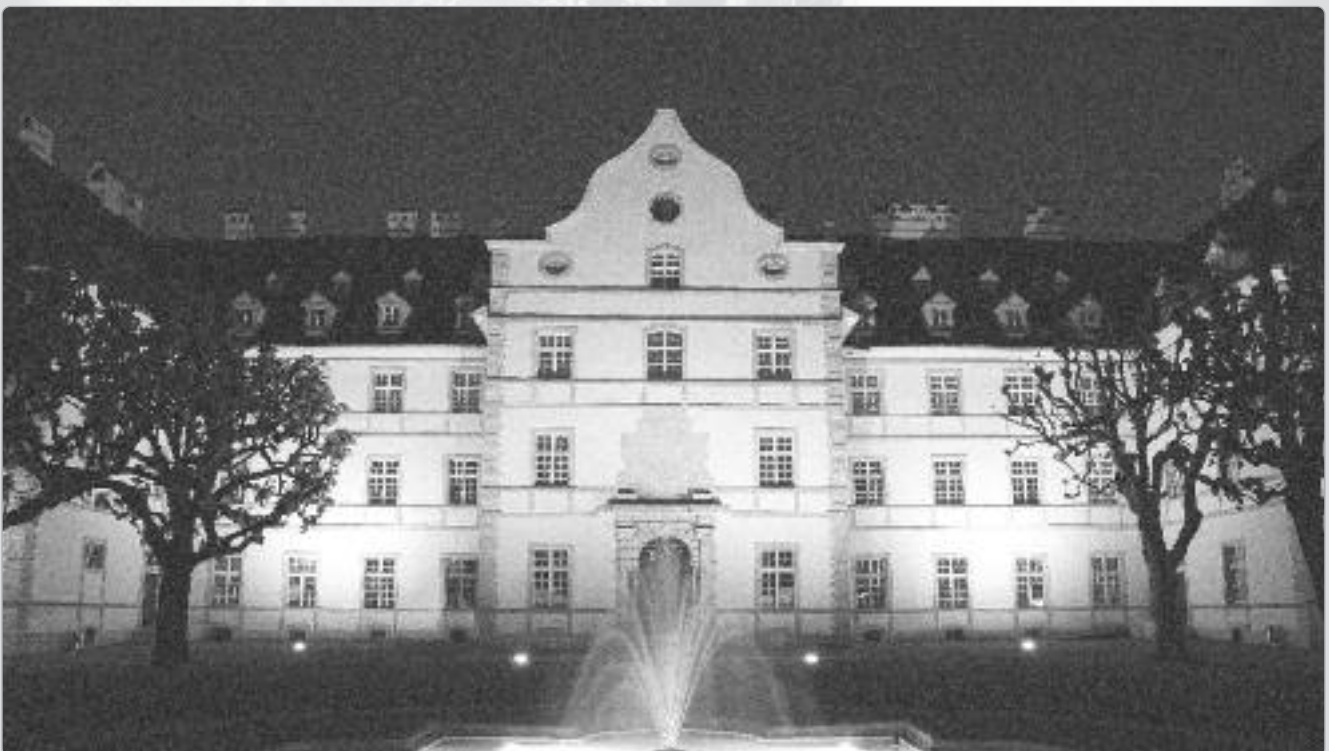
Château de Delémont, façade nord
