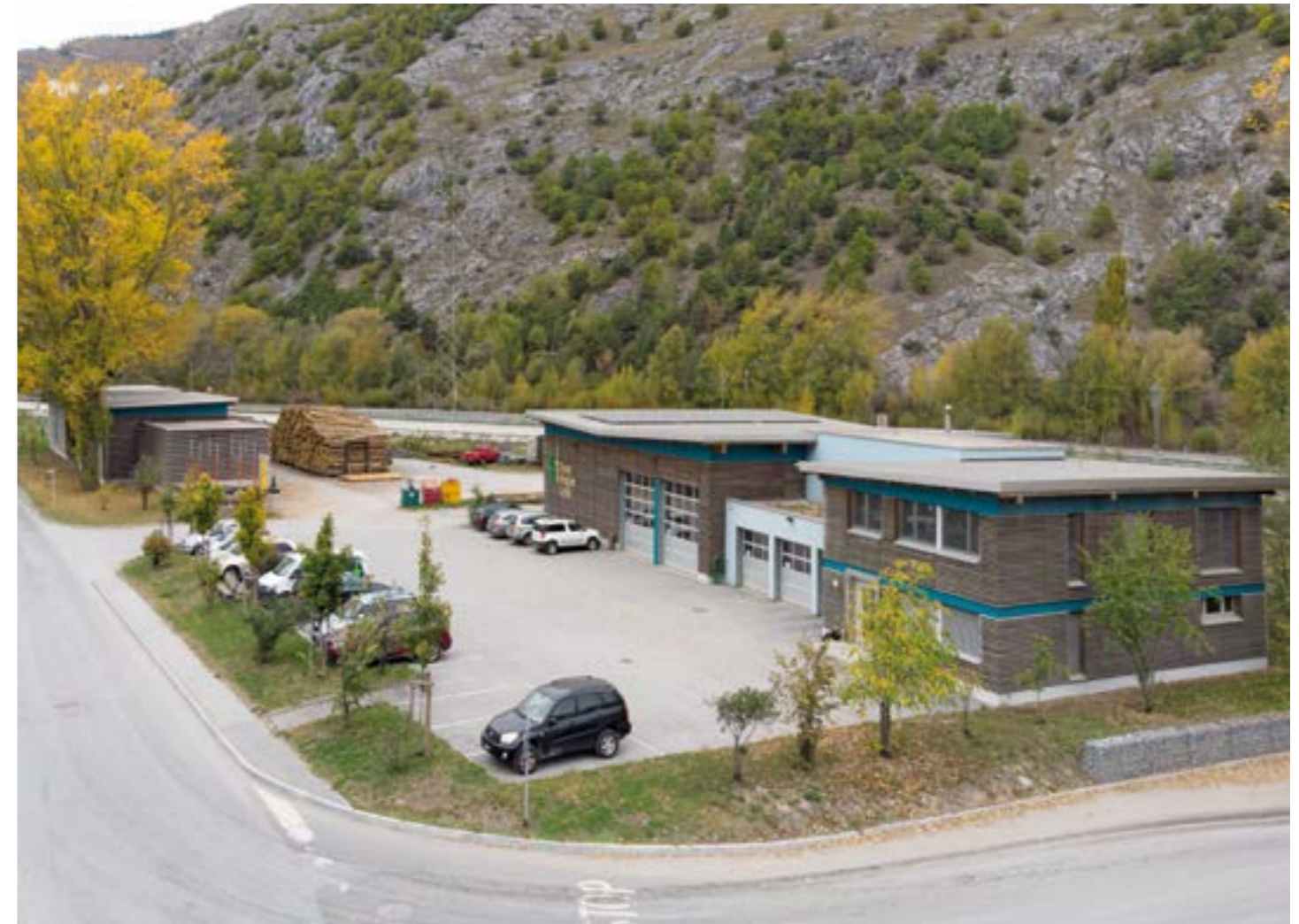
Der Forstwerkhof der Region Leuk (FRL)
