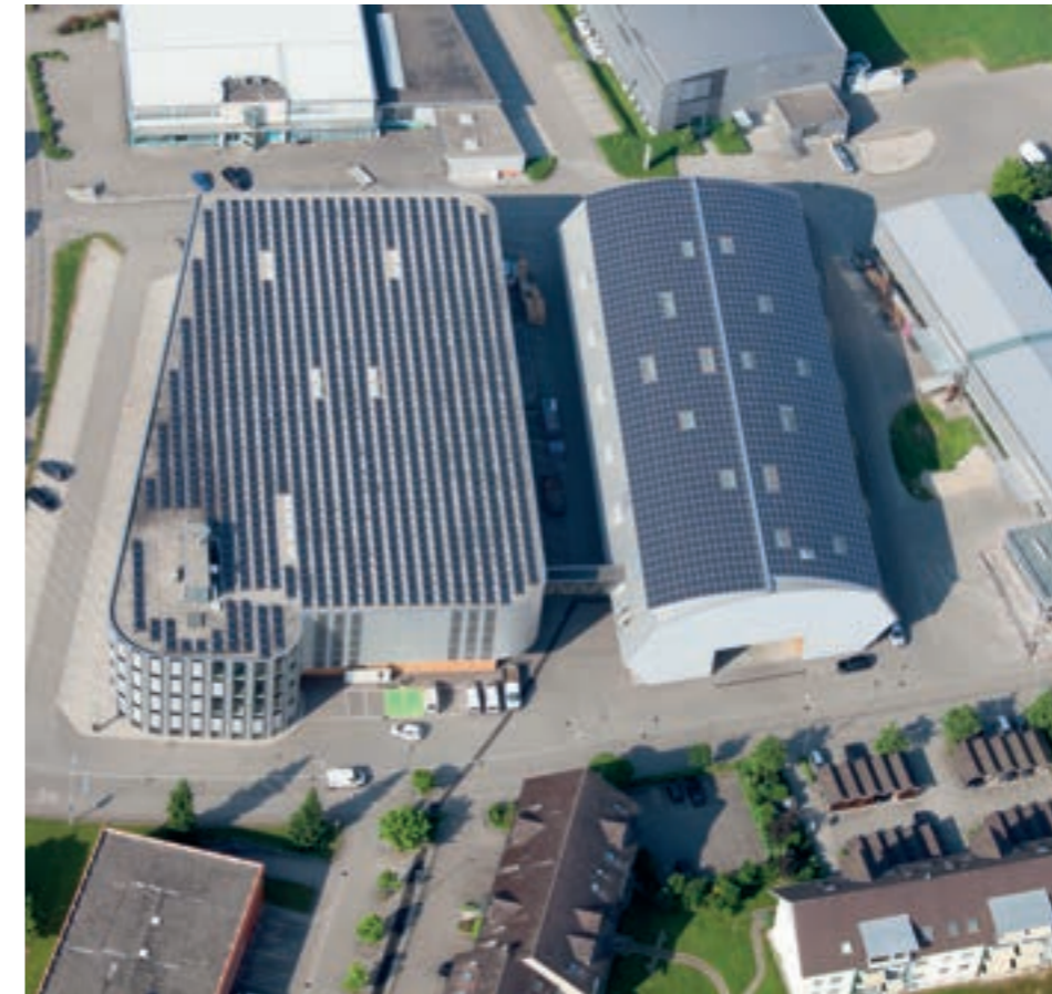
Die gesamte Energie für den Betrieb produziert Hector Egger Holzbau auf ihren Solardächern.
