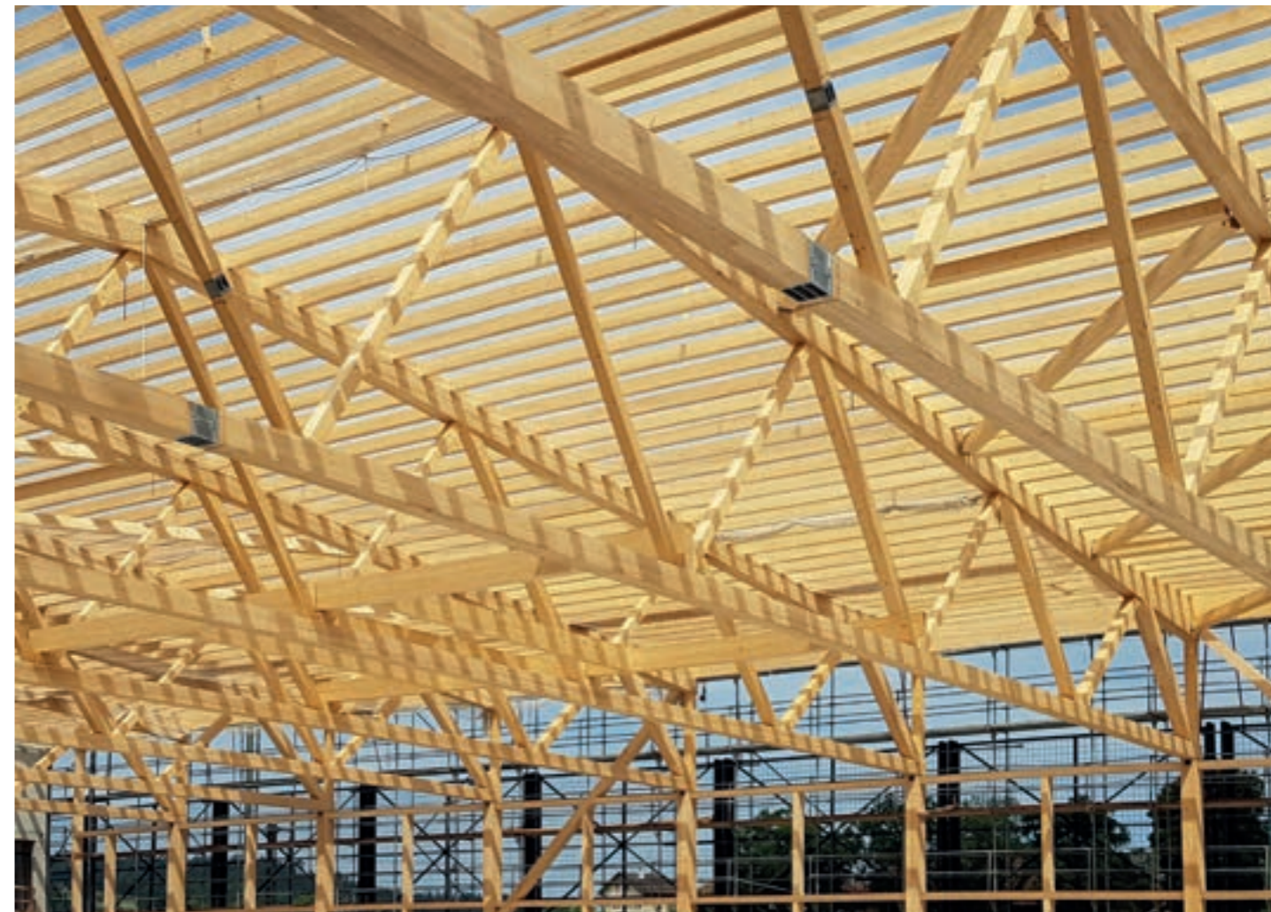
Nouvelle construction du stade de Pruntrut (Raiffeisen Arena): ossature de comble d'une portée allant jusqu'à 40 m en bois feuillu (frêne).
